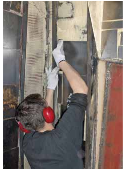
Stålplader er limet på for at dæmpe støjen. (Foto: Karsten Korsgaard)
