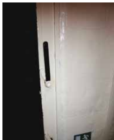
Skot med hvid asbest. Overflade med lærred og bemaling i høj glans. Asbesten er forseglet tilfredsstillende.
