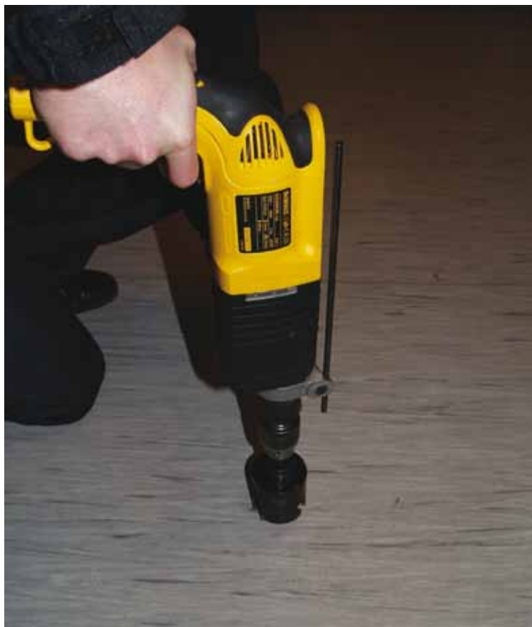
Boring med kopbor i fast banelægning på gulv. Vinyl og bitumenklæber kan indeholde asbest. Husk alle lag i plastpose og nummeridentifikation.
